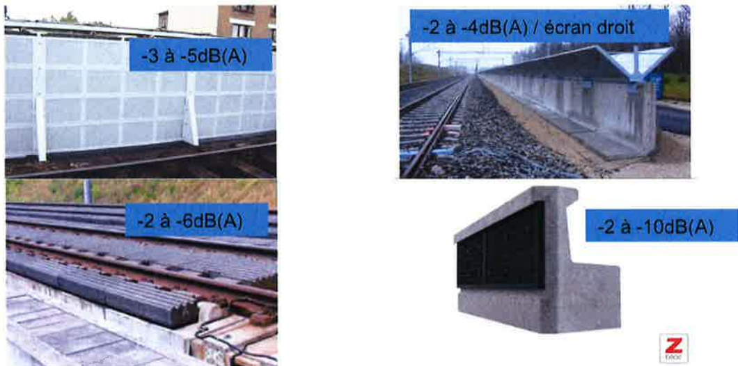
Figure 20 : Illustration de plusieurs types de solution de réduction du bruit entre une source et un récepteur.
