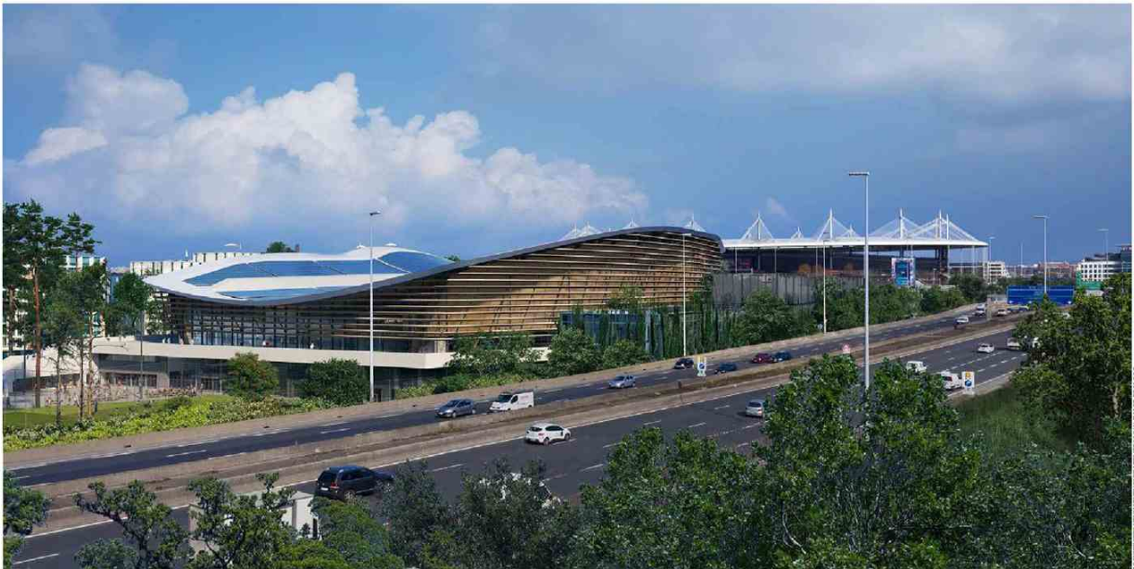
Dans la ZAC Plaine Saulnier, à deux pas du Stade de France, le futur Centre aquatique olympique rayonnera sur 2,4 hectares.
