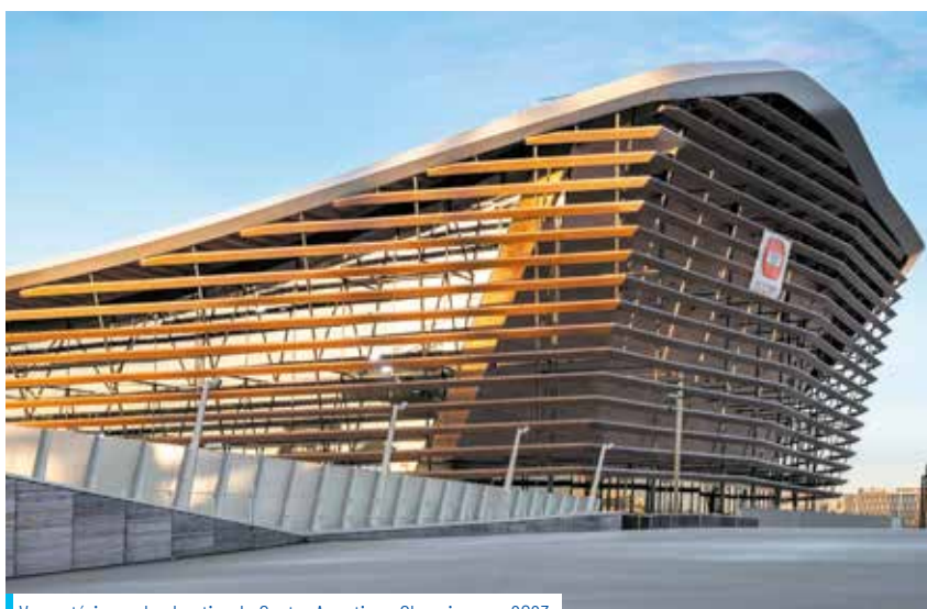
Vue extérieure du chantier du Centre Aquatique Olympique en 2023.
