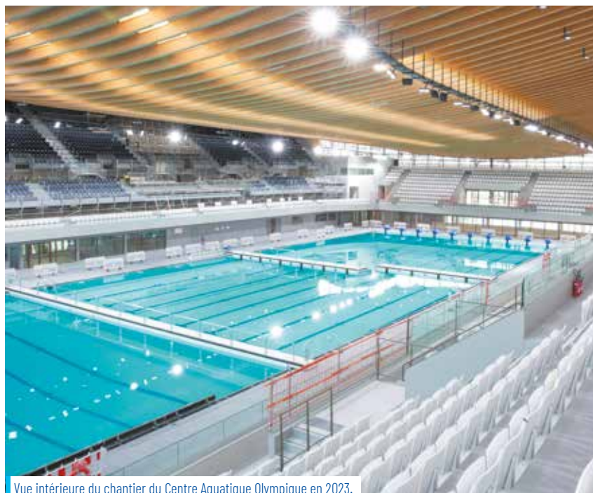
Vue intérieure du chantier du Centre Aquatique Olympique en 2023.
