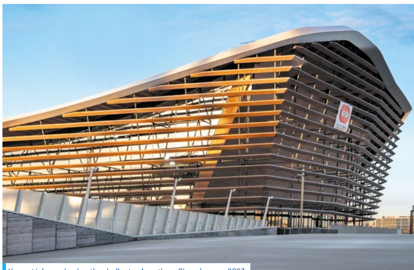
Vue extérieure du chantier du Centre Aquatique Olympique en 2023.
