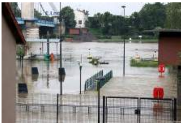
Berges inondées à Alfortville. Sources : IAU-Îdf, juin 2016
