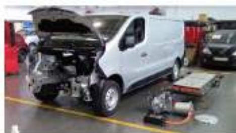
Remplacement de la transmission diesel d'un Renault Traffic par une transmission électrique par l'entreprise CarWatt.
